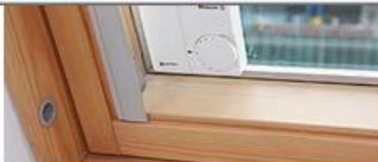
Das Funkthermostat reguliert die Heizung
