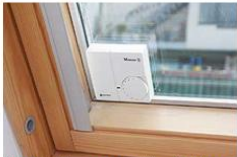
Das Funkthermostat reguliert die Heizung
