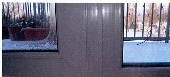
VORHER, NACHHER: Links ein Fenster ohne T-Stripe, rechts mit dem Fensterheizsystem.
